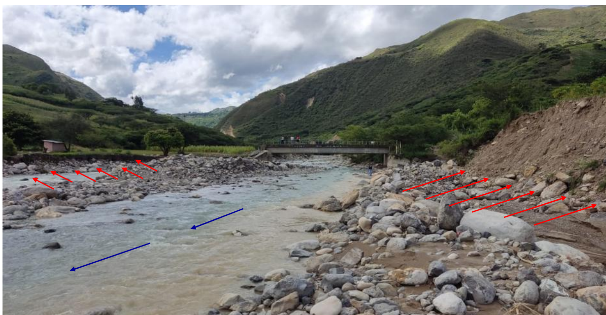
FOTOGRAFIA N°03: SOCAVACIÓN EN AMBAS MARGENES DEL RIO CHOTANO EN LA TEMPORADA DE MAXIMAS AVENIDAS.
